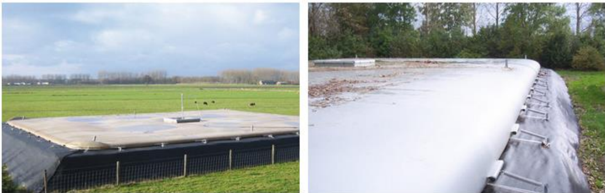
Photographie 20 : Exemples de poche de stockage de digestat (Source : Albers Alligator)
