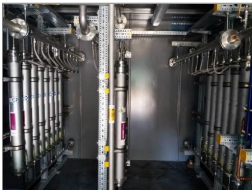
Photographie 24 : Système d'épuration membranaire (Source : agriKomp)
